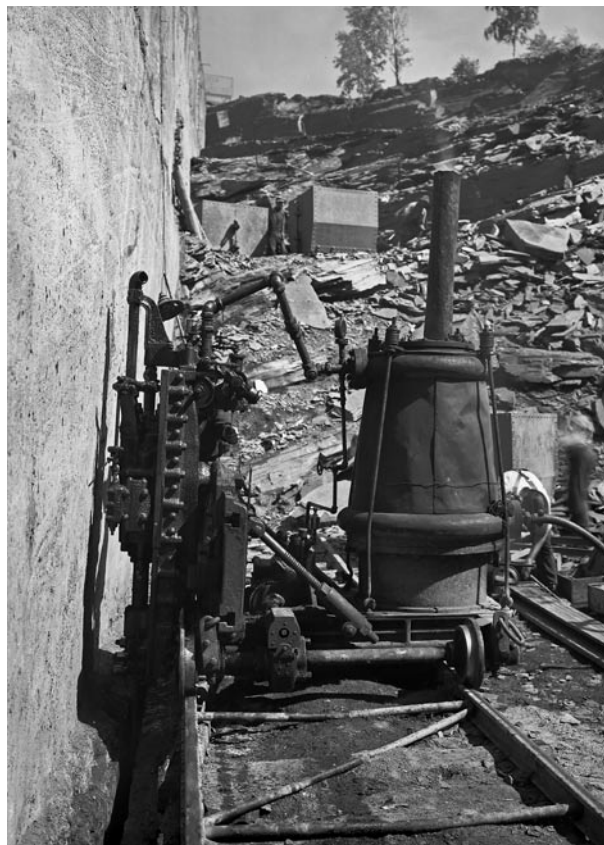
177 Dampfbagger. Die Eisenbahnen im und zum Bruch sind Karl Oertels Werk. Die weitere Technisierung erlebt der große Unternehmer nicht mehr. Dampfbagger, Schrämmaschinen und Preßluftbohrer kommen erst nach seinem Tod. Aufnahme im Abraumbetrieb mit dem 1905 gebauten Bagger der Hamburger Firma Menck & Hambrock , wohl kurz nach der Anlieferung.
