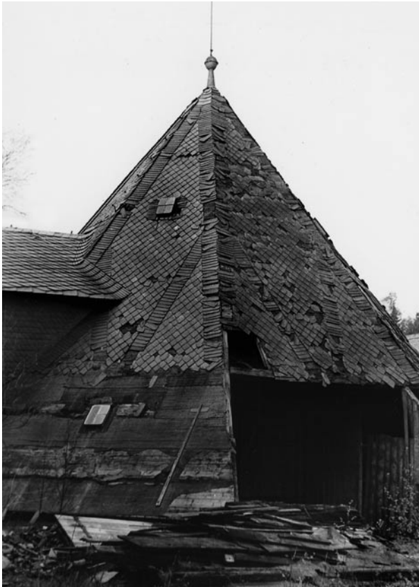
103 Der Göpel vor der Renovierung.
