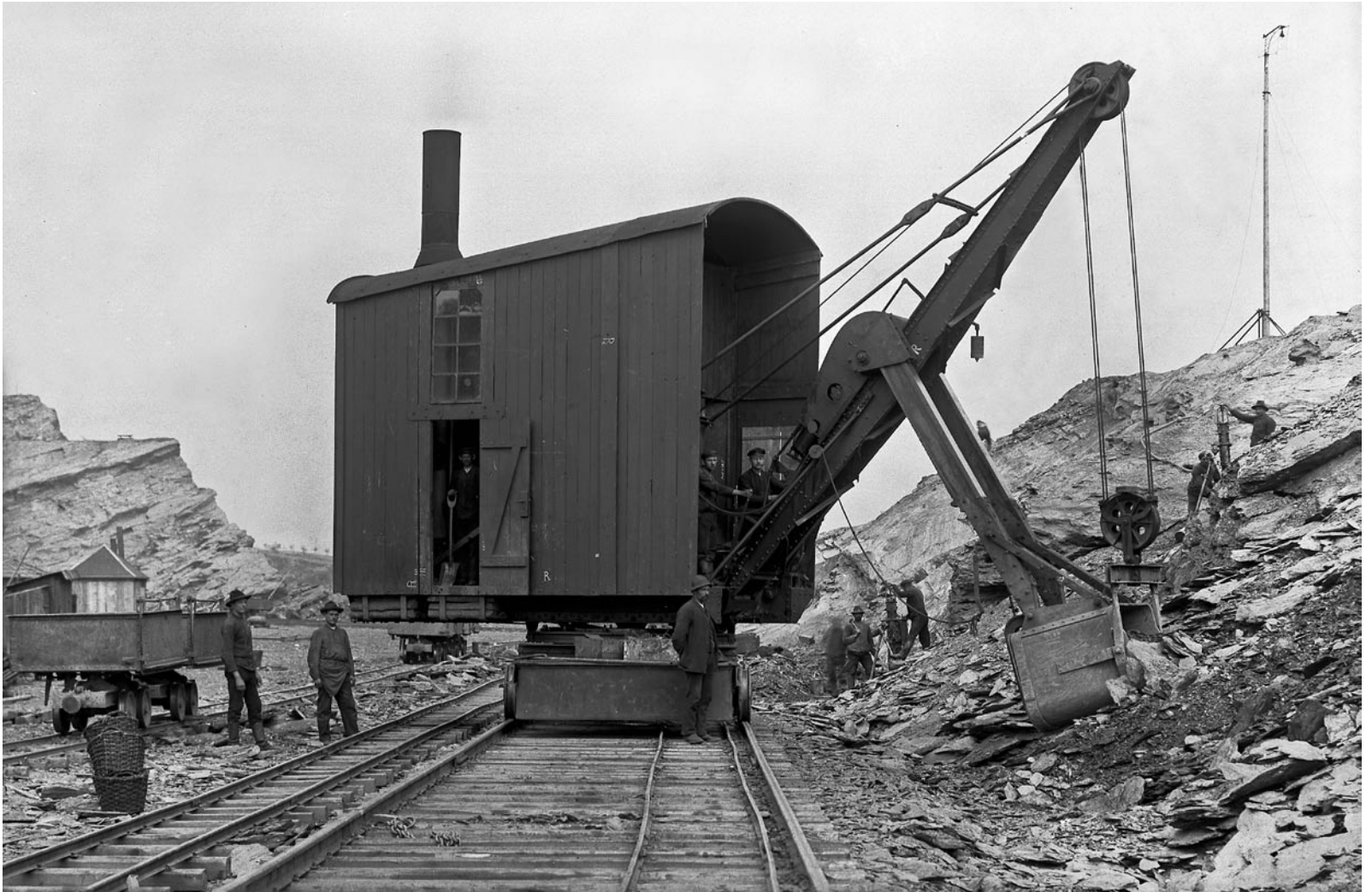
177 Dampfbagger. Die Eisenbahnen im und zum Bruch sind Karl Oertels Werk. Die weitere Technisierung erlebt der große Unternehmer nicht mehr. Dampfbagger, Schrämmaschinen und Preßluftbohrer kommen erst nach seinem Tod. Aufnahme im Abraumbetrieb mit dem 1905 gebauten Bagger der Hamburger Firma Menck & Hambrock , wohl kurz nach der Anlieferung.
