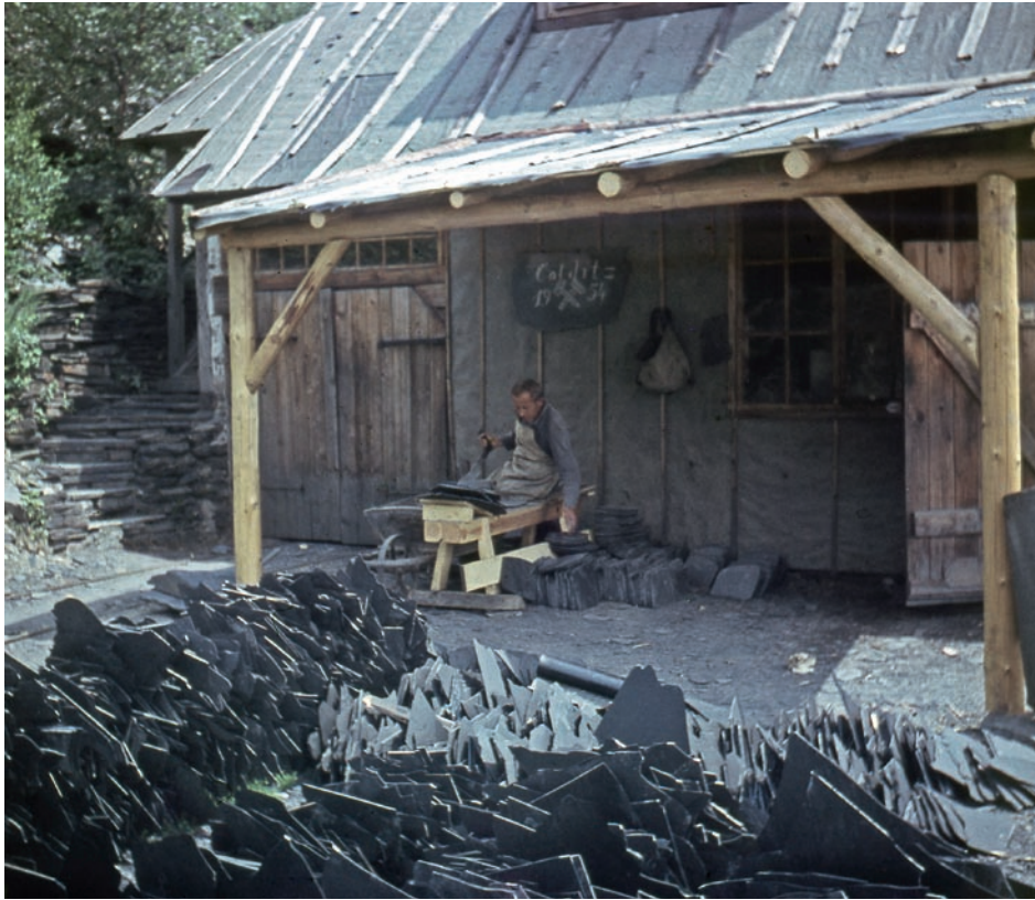
216 Spalthütte KOLDITZ 1954. Der womöglich einzige Zuschneider des kleinen Betriebes hat seinen Arbeitsplatz ins Freie verlegt, was des Staubes wegen auf jeden Fall gesünder ist. Der Arbeitsvorrat ist im Vordergrund gestapelt. Die Hütte auf der 407 m-Sohle ist 1951 als Ersatz für den abgebrannten Vorgänger nur notdürftig, ohne Dach- und Wand-schiefer, errichtet worden.
