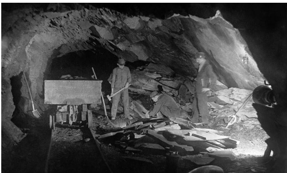
364 Rheinischer Abbau auf der 205 m-Sohle BRAND um 1957.
