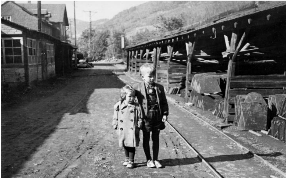
362 Tagesanlagen von BRAND (Revier II) 1954.
