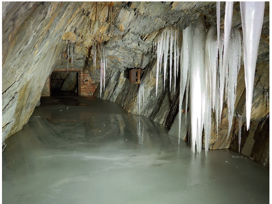
219 Eisbildung hinter dem Mundloch der 407 m-Sohle, Januar 2010.
